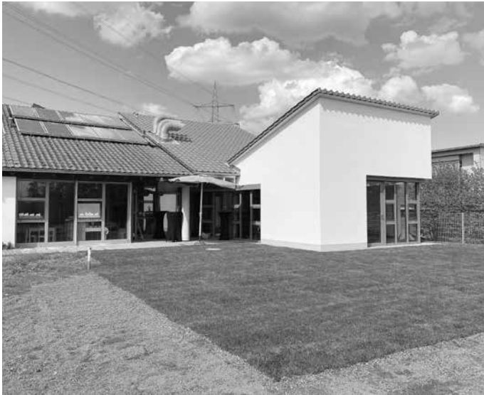
Blick auf den Anbau
